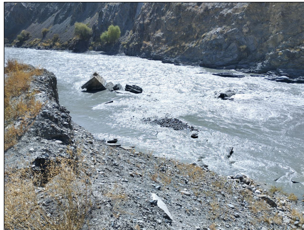
Повреждение берегов реки Зарафшон
