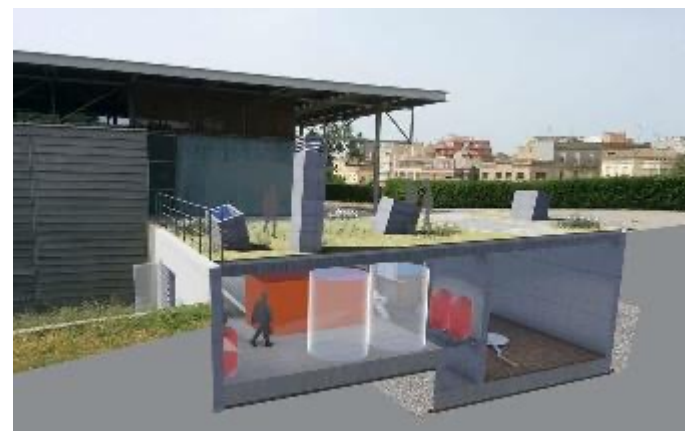
La Girada (Вилафранка-дель-Пенедес, Испания): котел мощностью 500 кВт, работающий на обрезках виноградников, используется для муниципального ЦТ. Источник изображения: Проект Vineyards4heat
