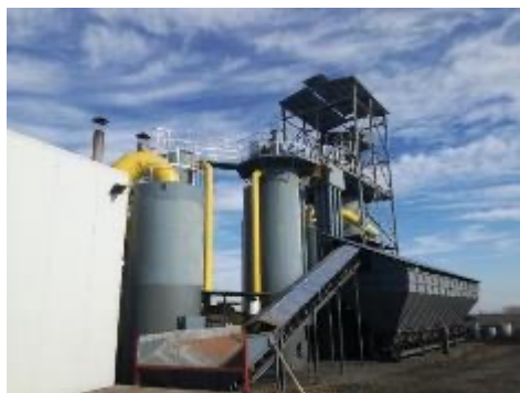
Vioenergiaki Patridas (Верия, Греция): газификатор мощностью 1 МВт, использующий древесную щепу, полученную в результате удаления персиковых деревьев с плантаций. Источник изображения: М. Карампинис
