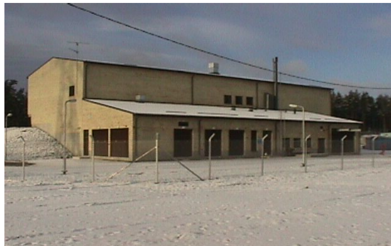
Станция очистки воды (обезжелезивания)
