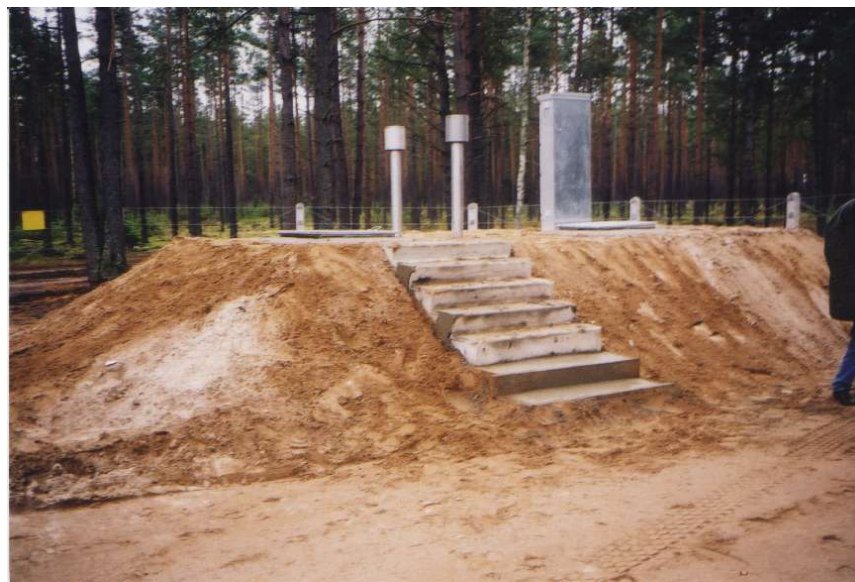
Водозабор – вид скважины снаружи
