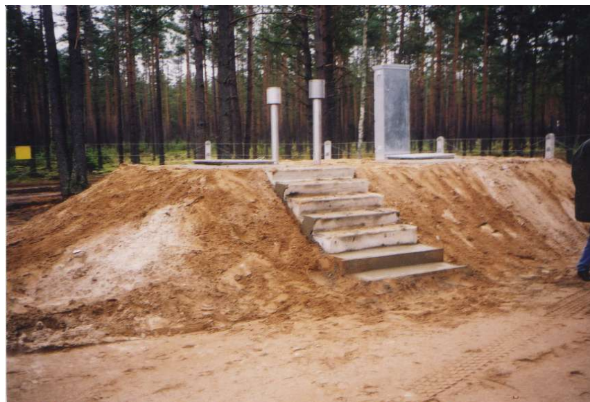
Водозабор – вид скважины снаружи
